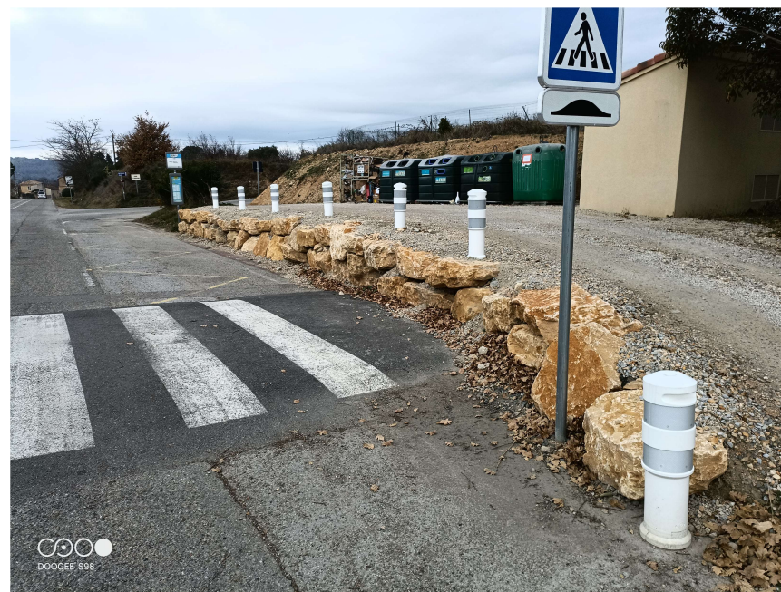
Aménagement zone déchets à l'Ouet du village
