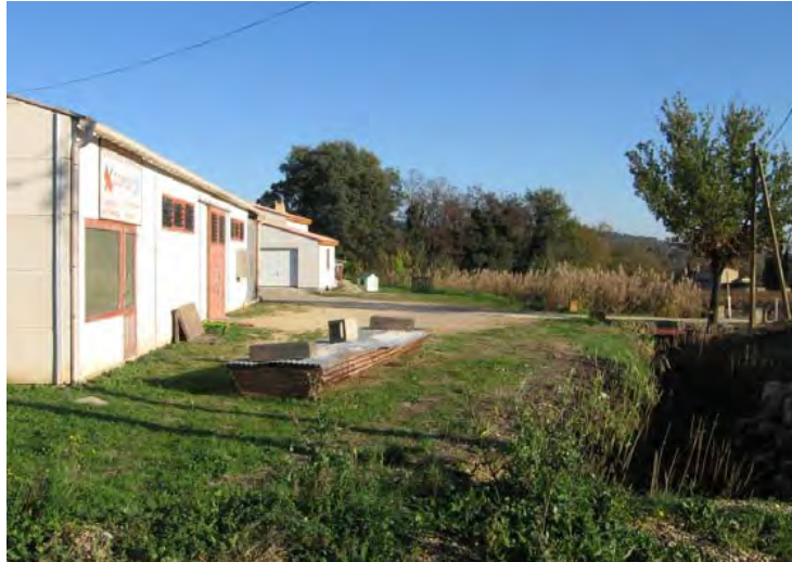
Constructions récentes vulnérables aux Prats
