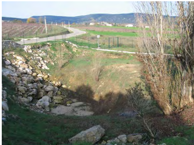
Captage d'eau dans une résurgence karstique
